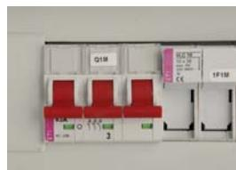
Подача питания на щит управления осуществляется при помощи главного выключателя (QM1). Нормальные параметры электрического питания и работа BIOS отображаются на плате контроллера светодиодами оранжевого и зеленого цвета соответственно.
